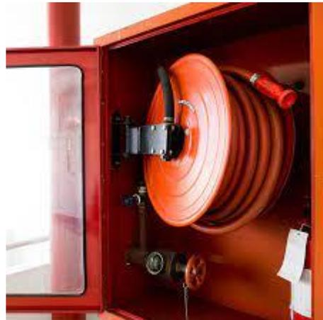
Un secondo prototipo di idranti a muro è costituito dai cosiddetti naspi, le cassette con tubazioni semirigide da 20 o 25 mm, provviste di un avvolgitubo orientabile, con la tubazione già direttamente congiunta alla lancia e al rubinetto. I naspi presentano l'indubbio pregio di una maggiore facilità di impiego, ma hanno una gittata idrica minore rispetto alle manichette; sono, inoltre, più ingombranti e per tale ragione risulta più arduo adoperarne le varianti ad incasso.
